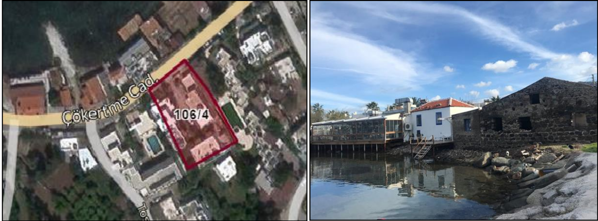
Resim 1. Uygulama sahasındaki 1000 nolu parsel (yeni 106 ada- 4 parsel) ve komşuluğunda olup kıyı alanında (karayolunun deniz tarafında) kalan taşınmazların uydu haritası (a) (TKGM-Parsel Sorgu Sistemi) ile kıyı alanında kalan 998 nolu parsel üzerindeki yapı ve tesislerden bir görüntü (b) (2019).
